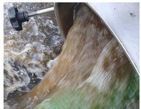
Abbildung 4: Trübung an der Auspeisestelle
