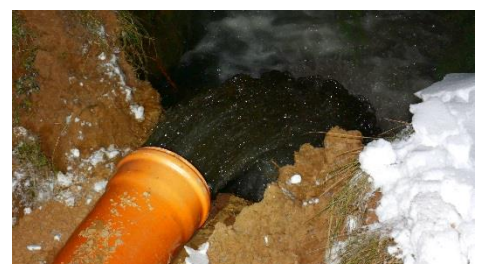
Abbildung 5: Spülwasser mit mobilisierten Ablagerungen an Ausspeisestelle
