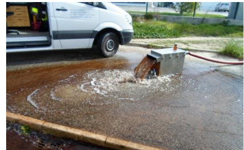
Abbildung 3: Trübung an Auslaufbox
