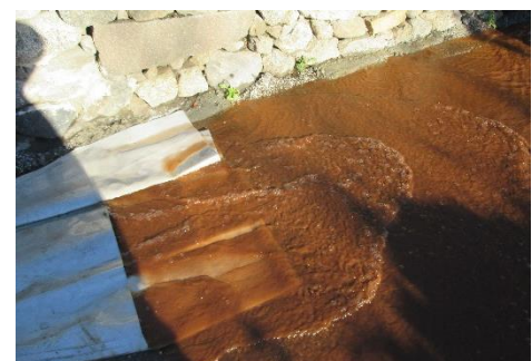
Abbildung 5: Spülwasser mit Trübung an der Ausspeisestelle
