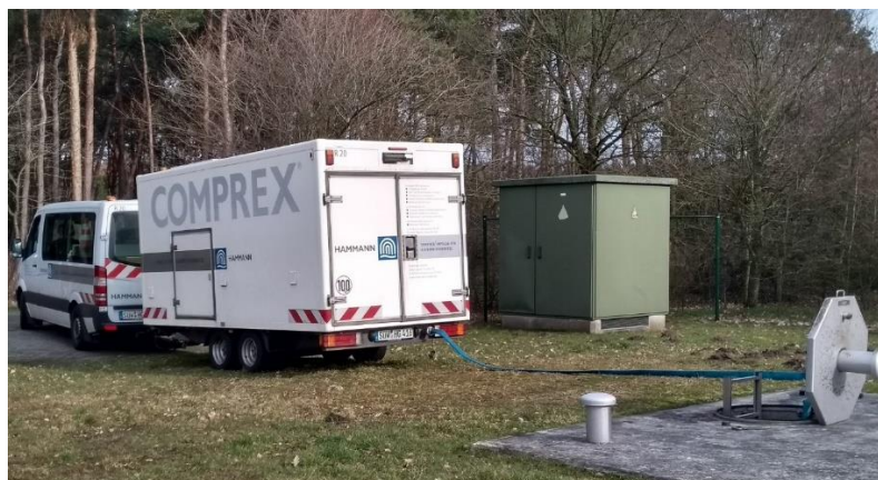
Abbildung 1: Comprex®-Einheit im Einsatz
