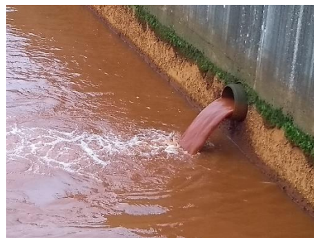
Abbildung 3: Freier Auslauf am Wasserwerk
