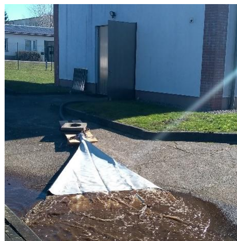
Abbildung 3: Ausspeisung am Wasserwerk
