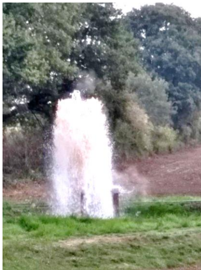
Abbildung 6: Ausspeisestelle während des Reinigungsvorgangs
