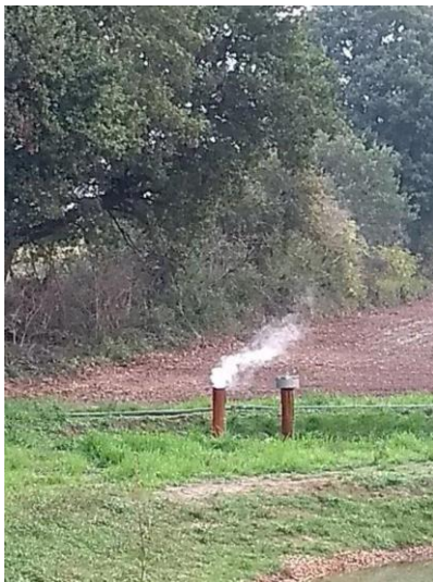
Abbildung 6: Ausspeisestelle während des Reinigungsvorgangs
