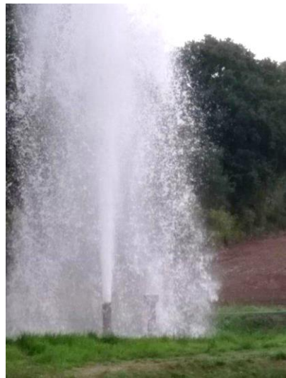
Abbildung 6: Ausspeisestelle während des Reinigungsvorgangs
