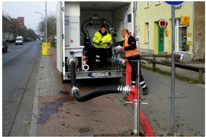
Abbildung 1: ExtraQt® im Einsatz vor Ort
