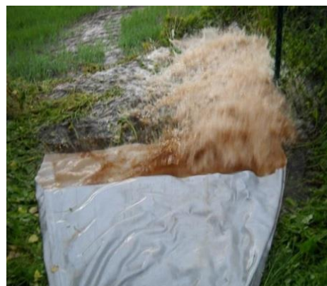
Abbildung 4: Trübung im Spülwasser an der Entnahmestelle
