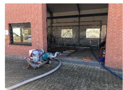
Abb. 4: Anschlüsse für comprex® und Spülwasser
