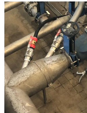
Abb. 3: Anschlüsse für comprex® und Spülwasser
