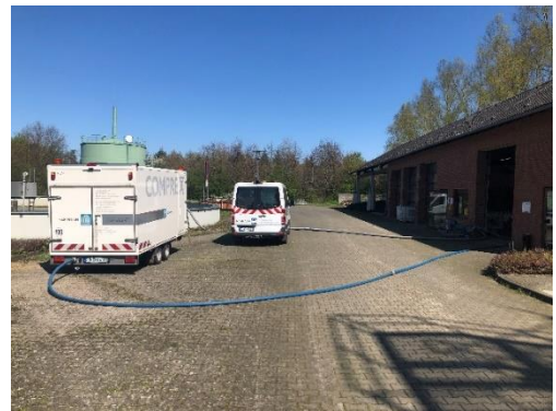
Abb. 1: Ansicht Kläranlage im Bereich Entwässerung
