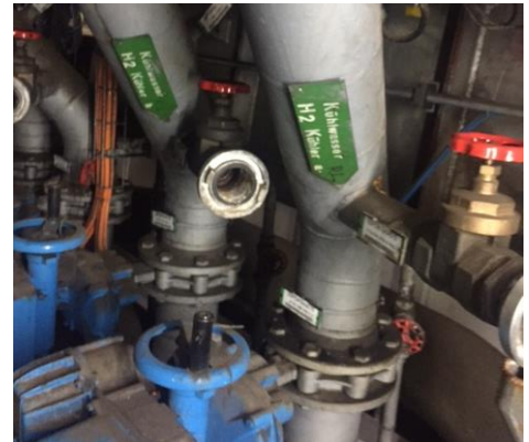
Abbildung 2: Zugang zum System über standardisierte Adapteranschlüsse
