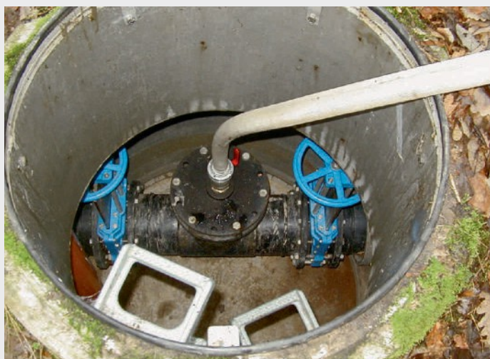
Fig. 4 Inlet points for compressed air in waste water pressure lines Bouches d'alimentation pour air comprimé dans les conduits de refoulement
