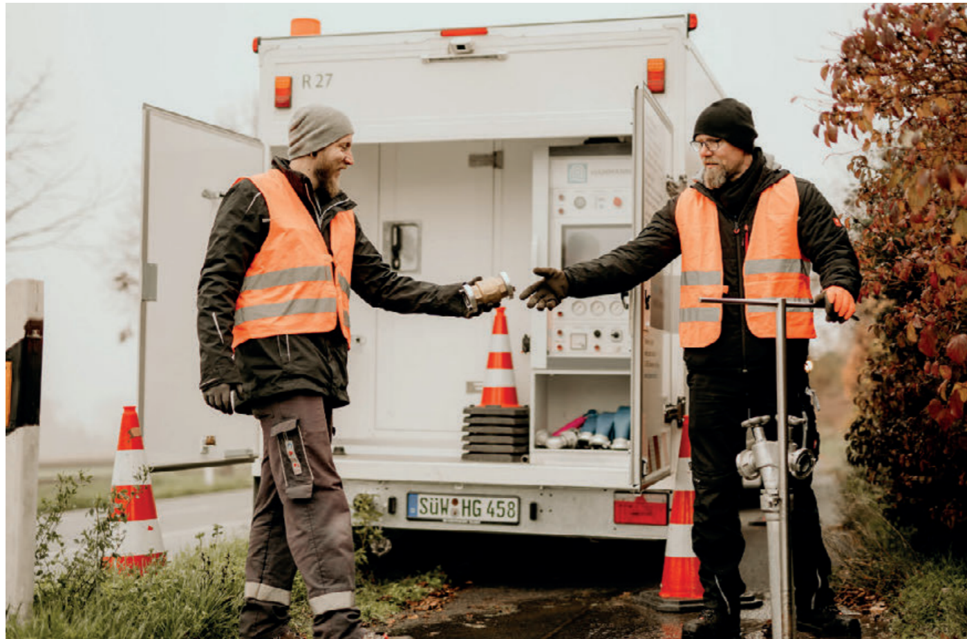
Bild 1 Mitarbeiter des Wasserversorgers und Hammann-Techniker vor dem Complex-Anhänger, der die Druckluftimpulse an der Einspeisestelle erzeugt. Quelle: Hammann GmbH
