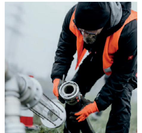
Bild 6 Schauglas an der Ausspeisestelle zur Kontrolle und Dokumentation der Trübung. Quelle: Hammann GmbH
